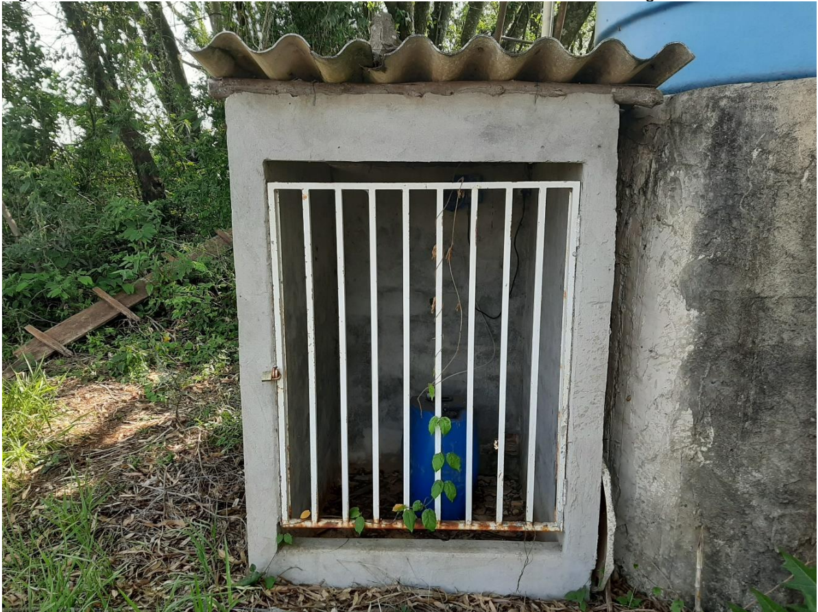
Figura 55: Tratamento - Linha Santana da Bela Vista – Armazenamento e dosagem cloro
