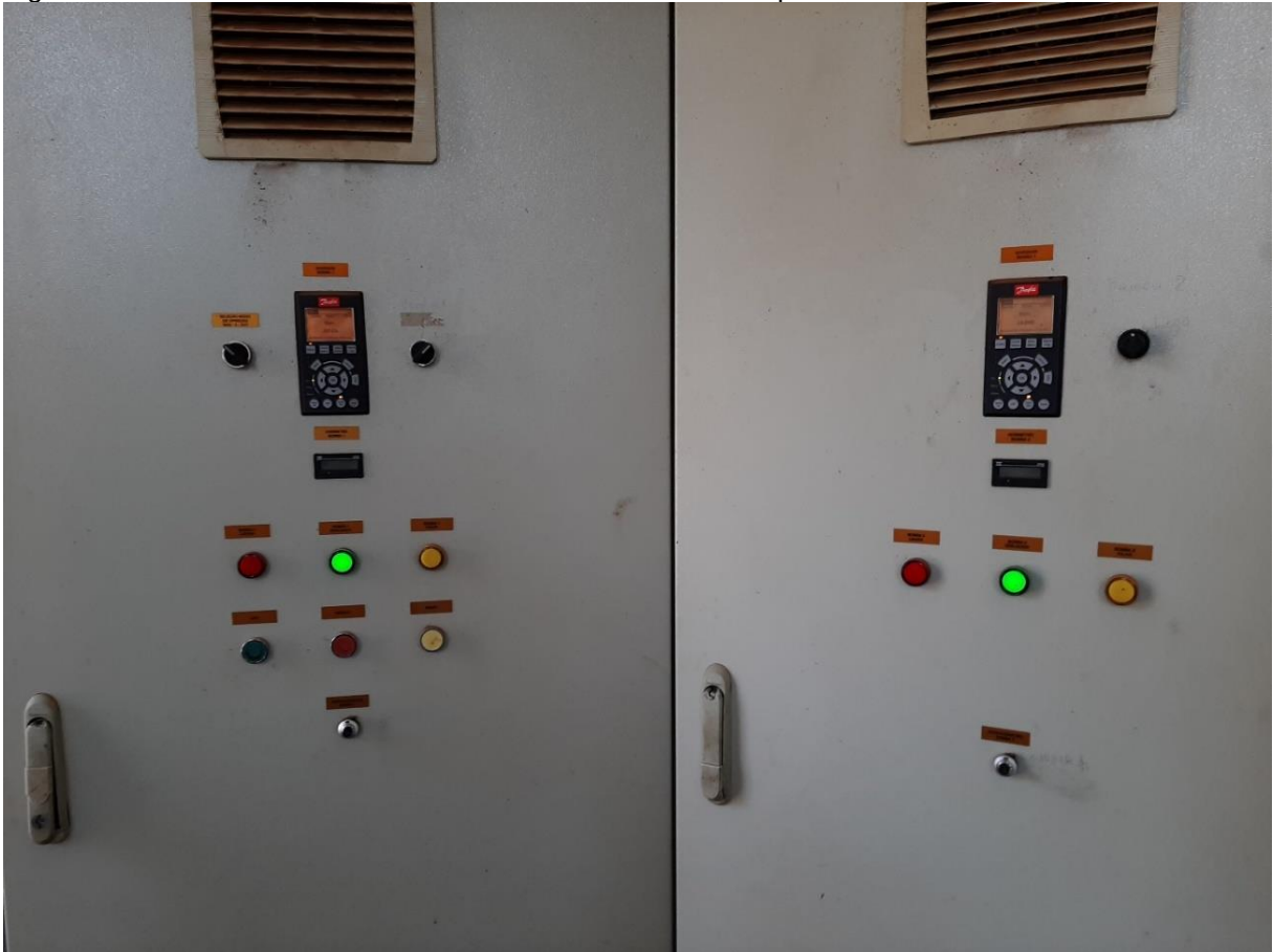
Figura 28: ERAT 01 – Painel de comando com inversor de frequência.
