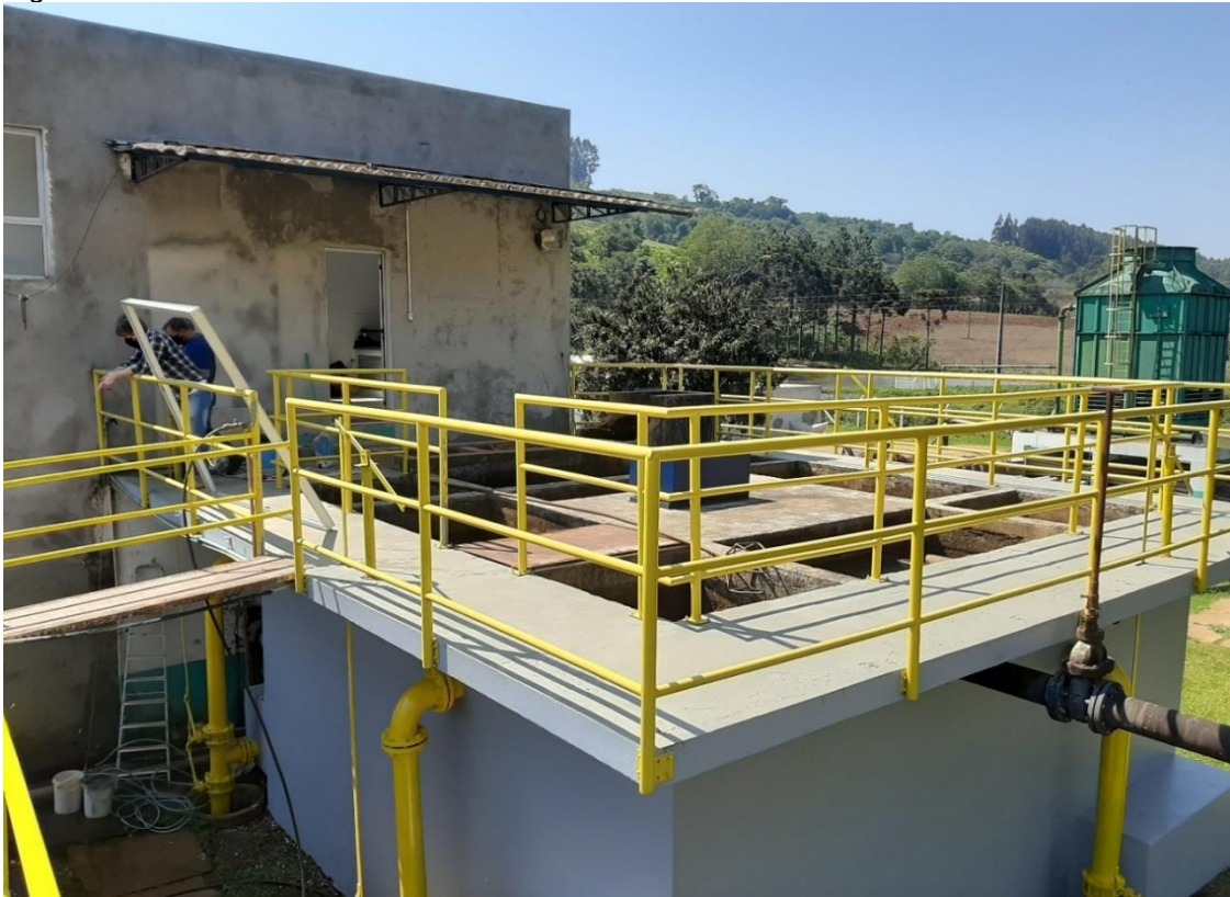
Figura 13: ETA – módulo em concreto.
