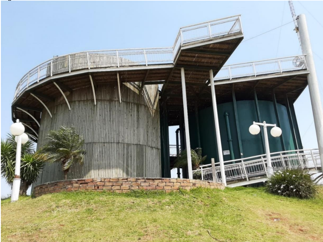
Figura 21: Reservatórios R.1 e R.2.
