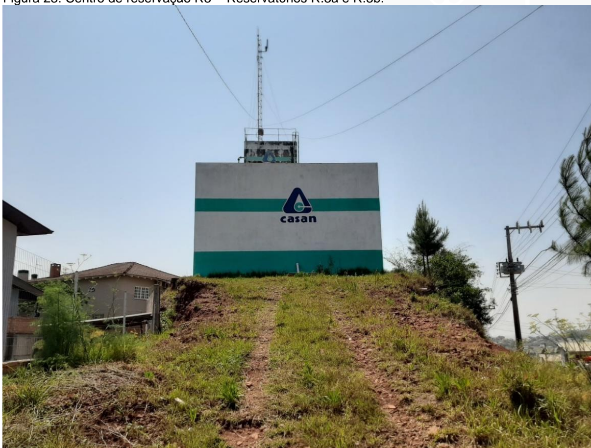
Figura 23: Centro de reservação R3 - Reservatórios R.3a e R.3b.
