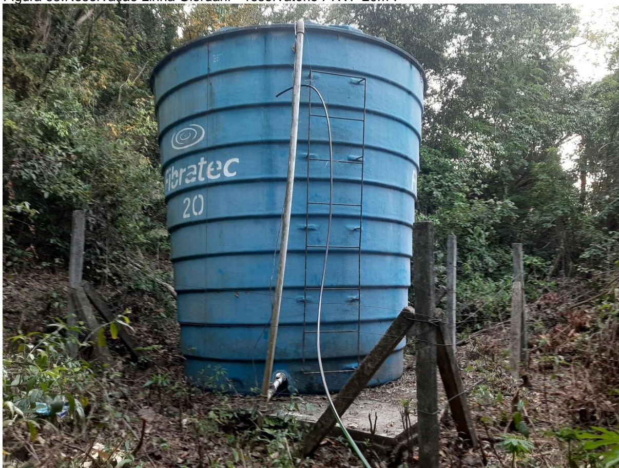
Figura 63: Reservação Linha Giordani – reservatório PRVF 20m³.
