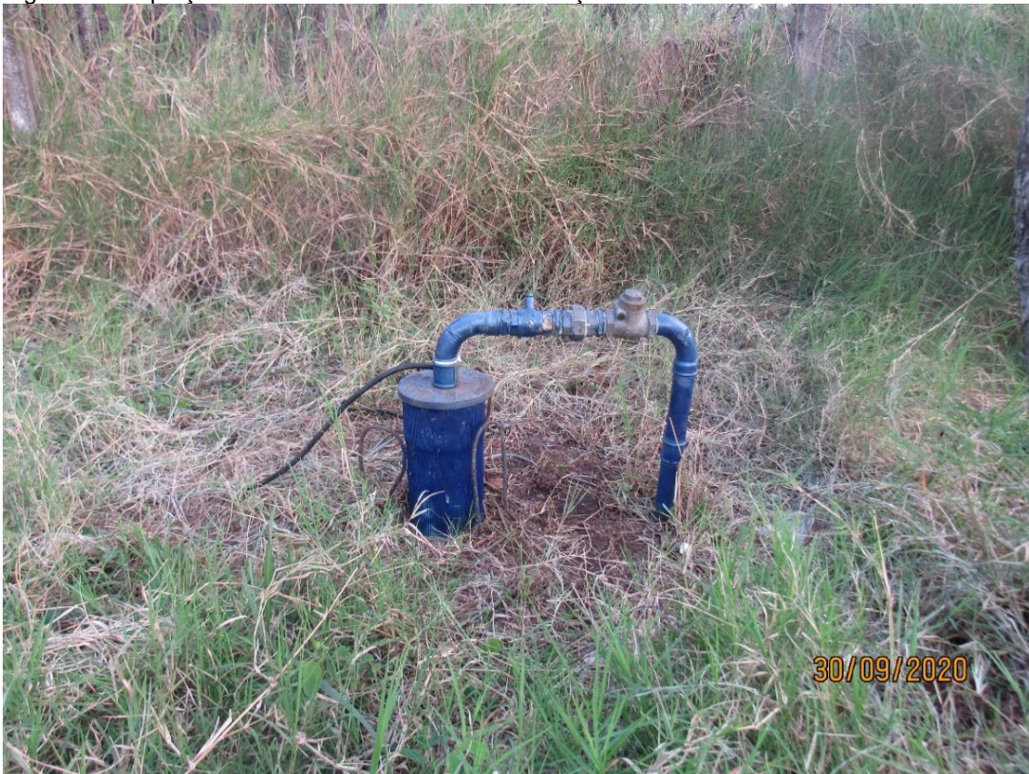
Figura 61: Captação Linha Giordani– Cavalete do Poço
