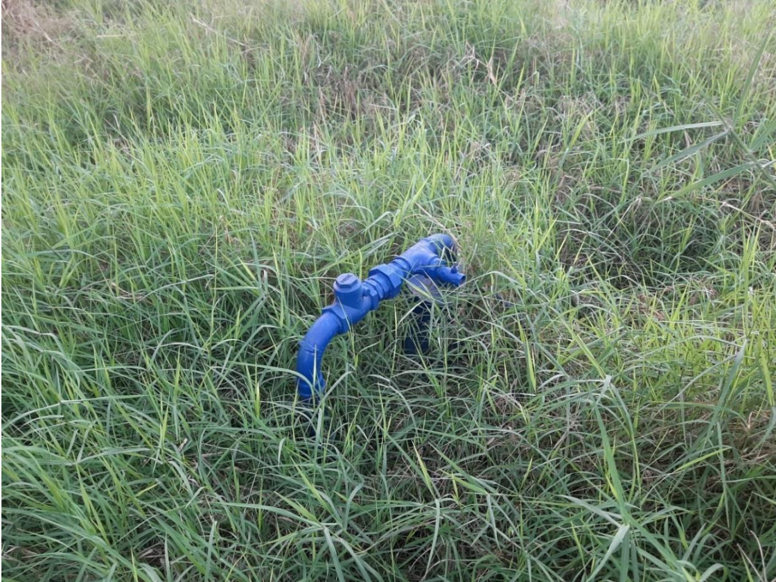
Figura 38: Cavalete do poço – SAA Distrito de Frederico Wastner.
