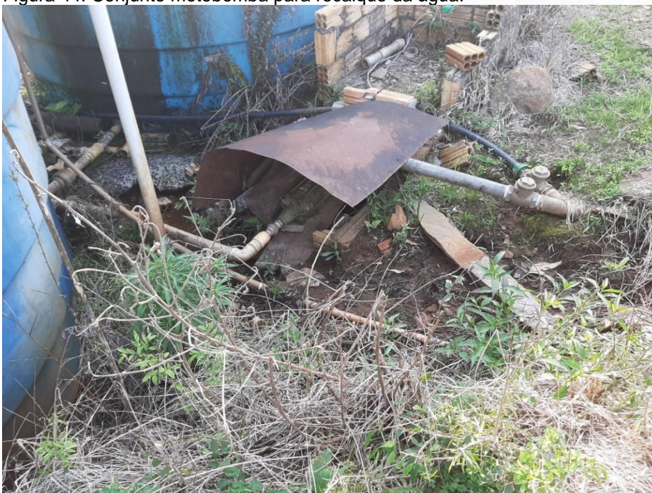
Figura 44: Conjunto motobomba para recalque da água.
