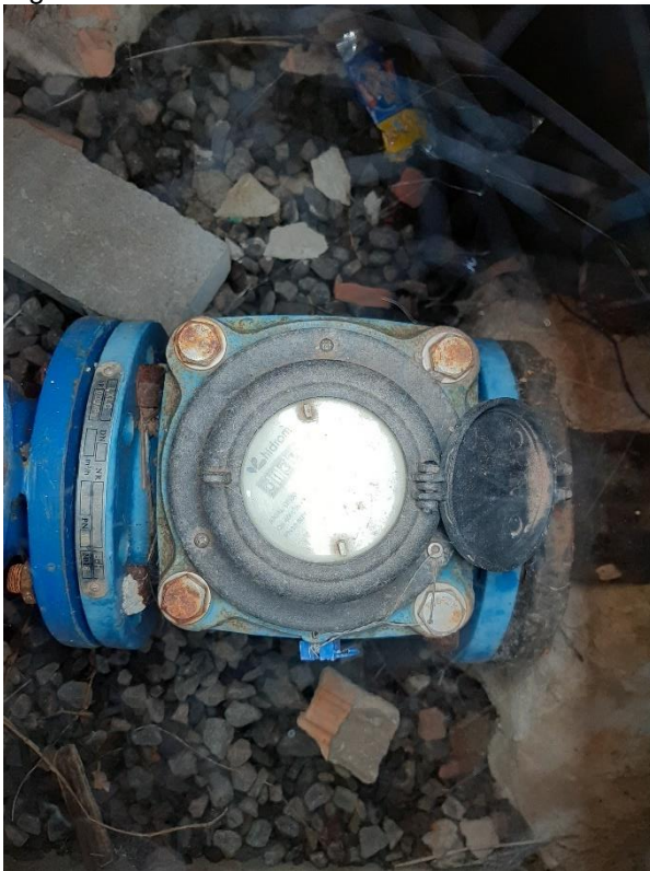
Figura 25: Macromedidor instalado na saída da reservação.
