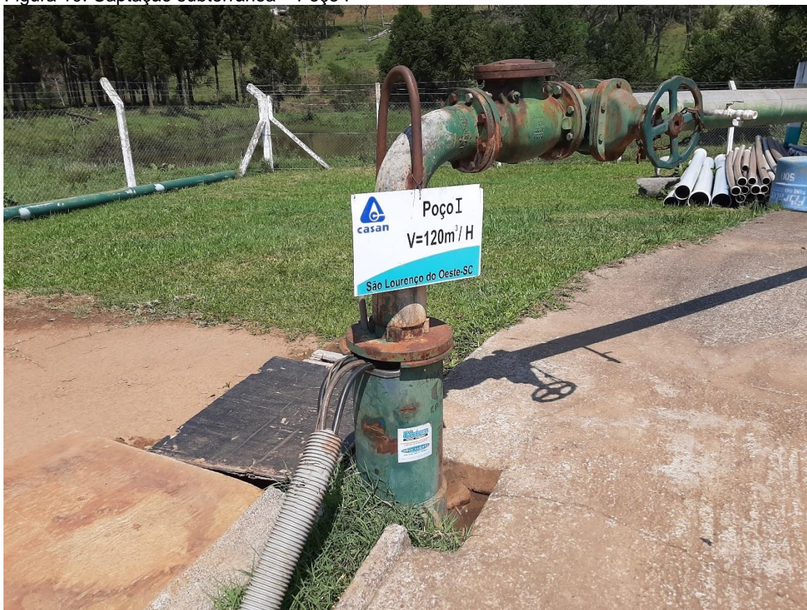
Figura 10: Captação subterrânea – Poço I
