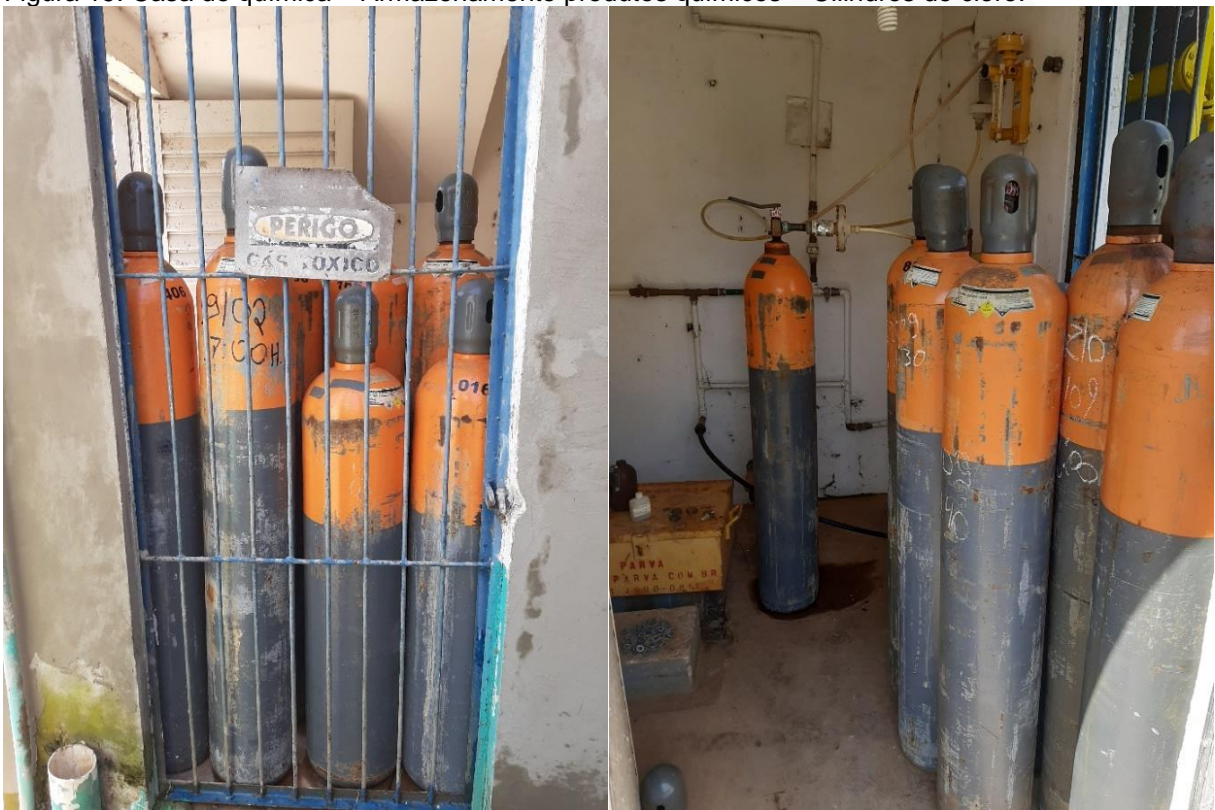
Figura 19: Casa de química – Armazenamento produtos químicos – Cilindros de cloro.
