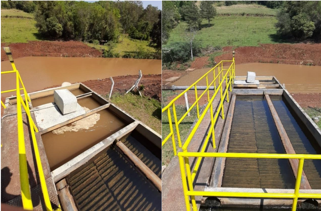
Figura 16: ETA metálica – vista superior.
