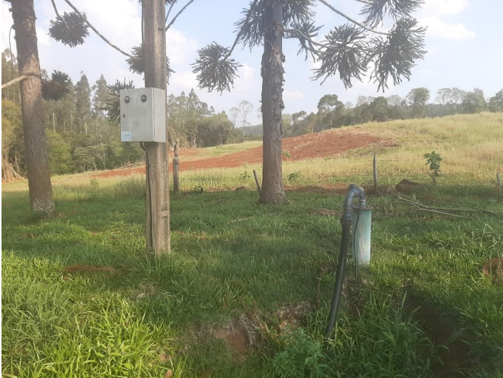
Figura 58: Captação Linha Santa Inês– Poço e painel de comando.
