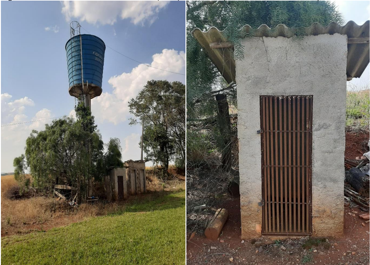
Figura 66: Reservatório em PRFV elevado (20m 3 ) e estrutura para armazenamento de químicos.
