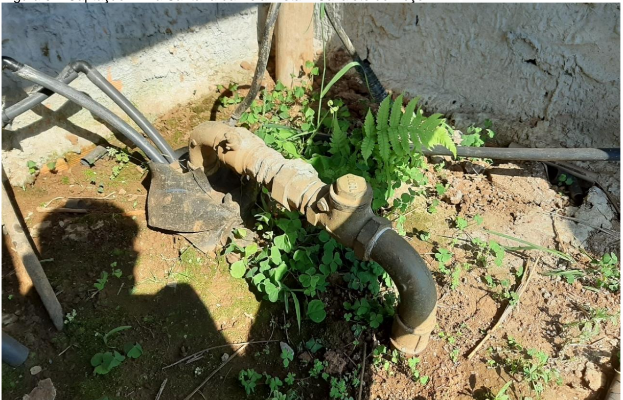
Figura 51: Captação Linha Santana da Bela Vista – Cavalete do Poço
