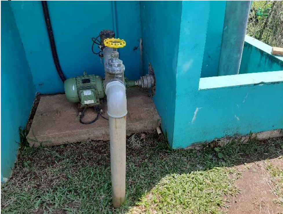
Figura 34: Booster 01 - 10 cv – ETA.
