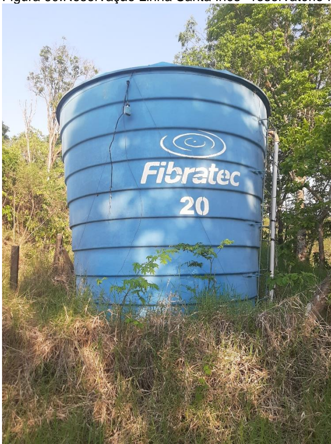
Figura 60:Reservação Linha Santa Inês– reservatório PRVF 20m³.
