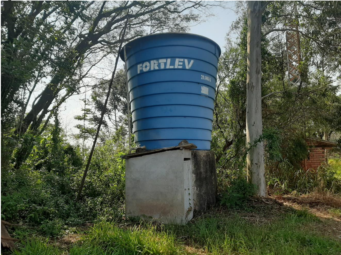
Figura 54:Reservação Linha Santana da Bela Vista – reservatório PRVF 20m 3 .
