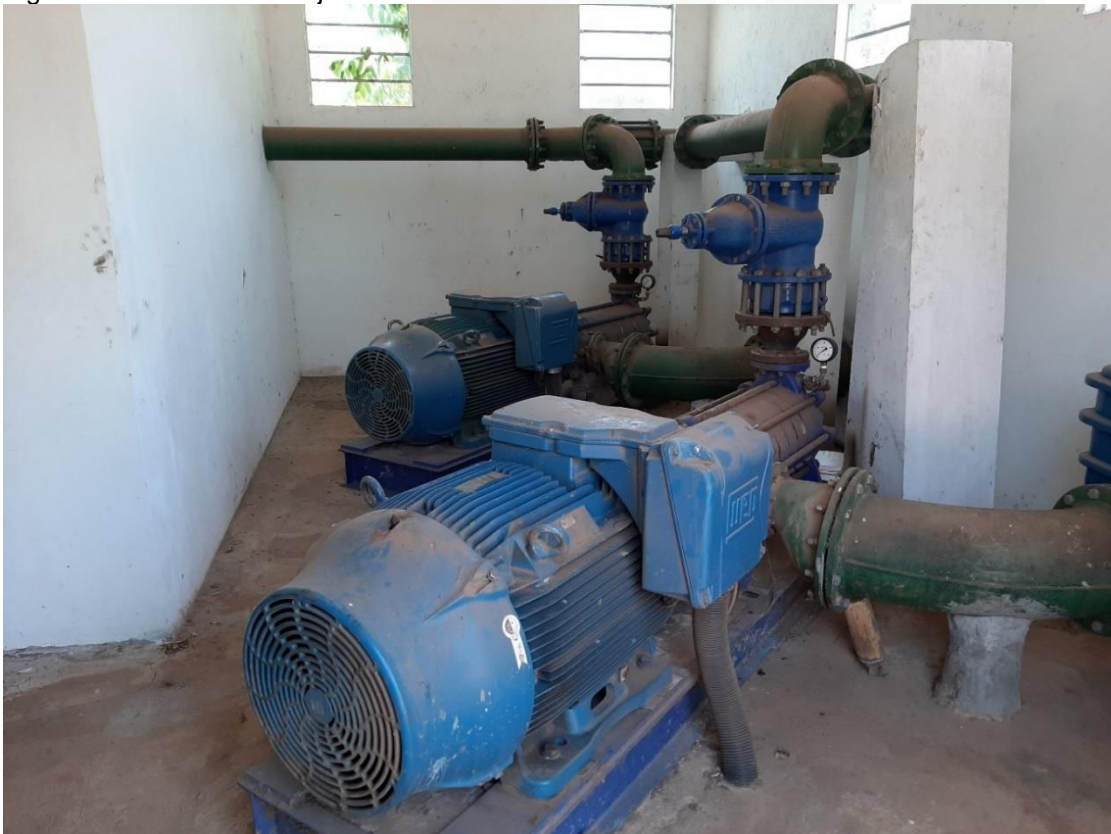
Figura 27: ERAT 01 – Conjuntos motobomba 200 cv.
