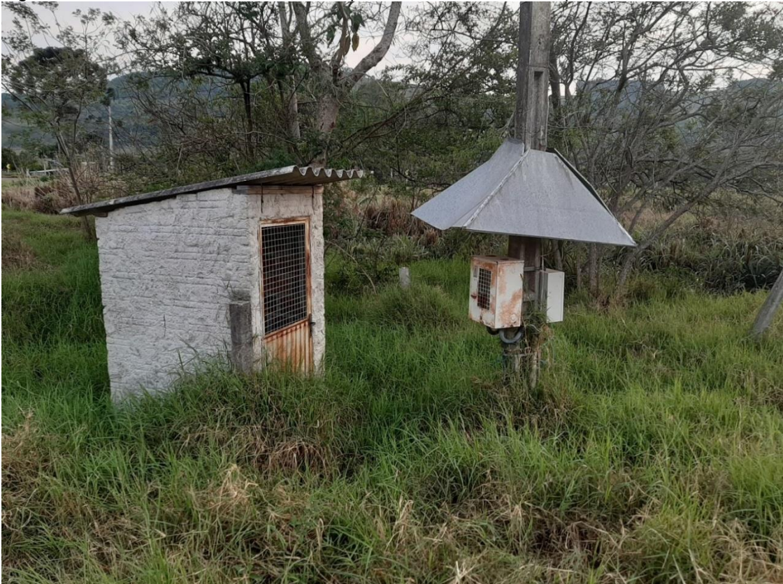
Figura 39: Painel de comando e estrutura para armazenamento de químicos.
