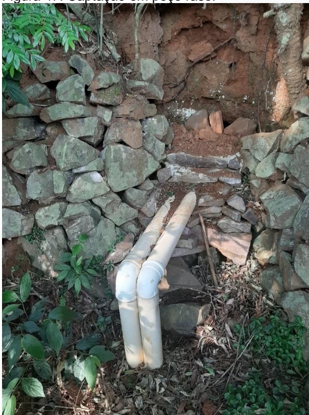
Figura 47: Captação em poço raso.
