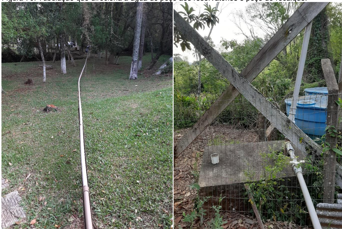
Figura 70: Tubulação que direciona a água do poço aos reservatórios e poço de recalque.
