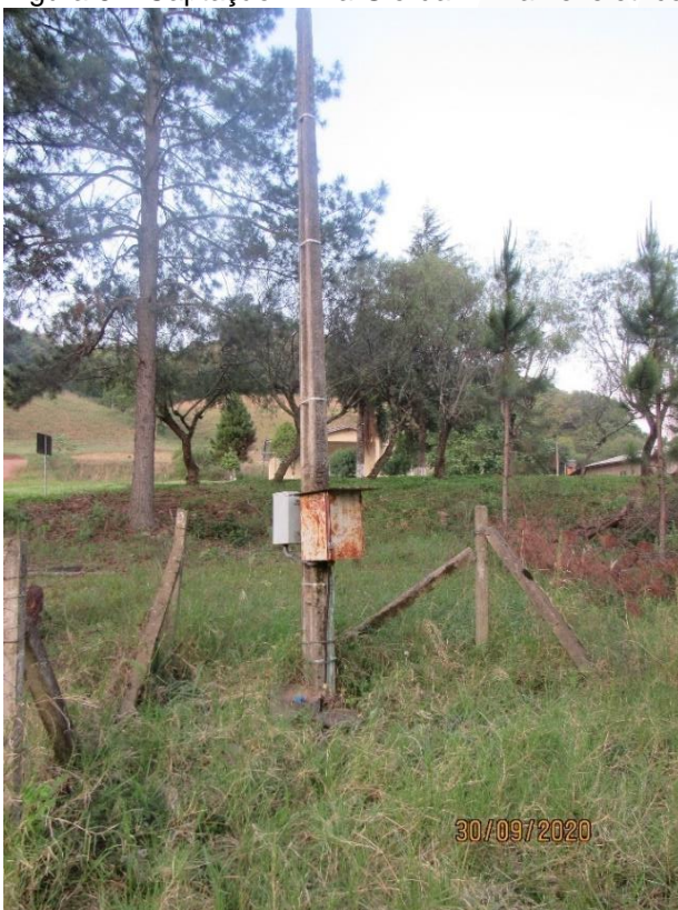
Figura 62: Captação Linha Giordani– Painelelétrico.
