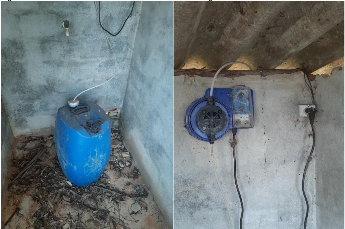
Figura 56: Tratamento - Linha Santana da Bela Vista – Dosagem de Cloro.
