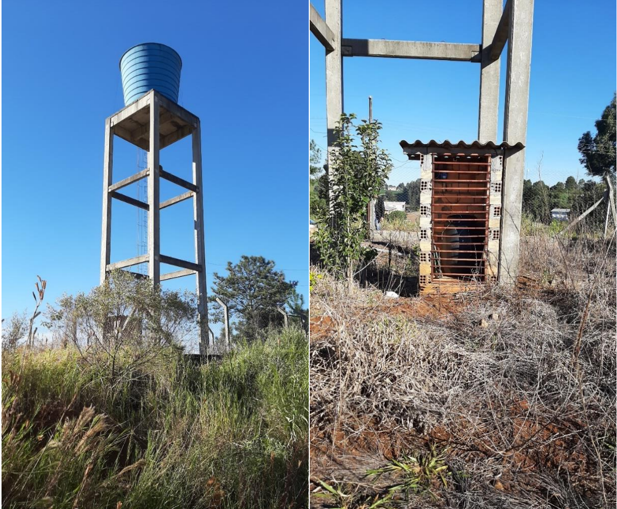
Figura 45: Reservatório e abrigo da bomba dosadora de cloro.
