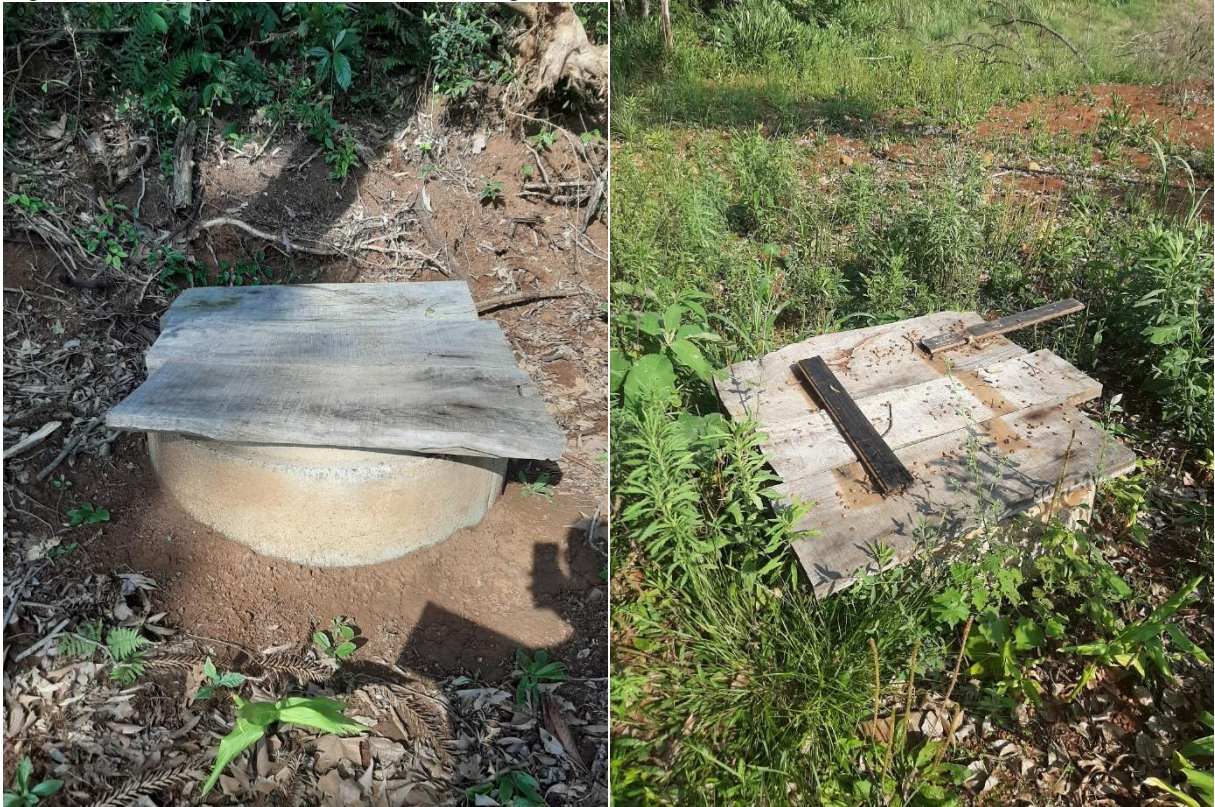
Figura 46: Captações em afloramentos d'água.
