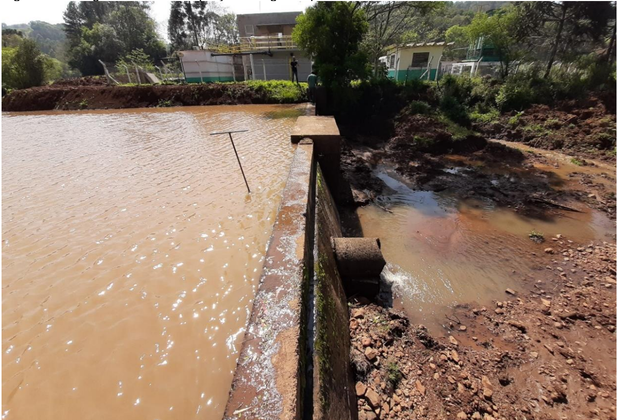
Figura 6: Barragem de nível - Captação de água superficial - Rio Macaco.
