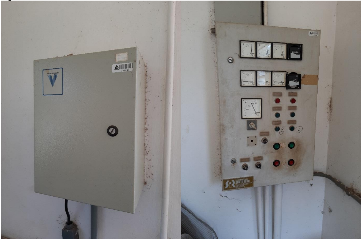
Figura 9: Painel de comando - ERAB.
