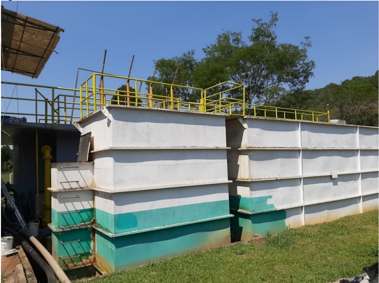
Figura 15: ETA metálica – vista lateral
