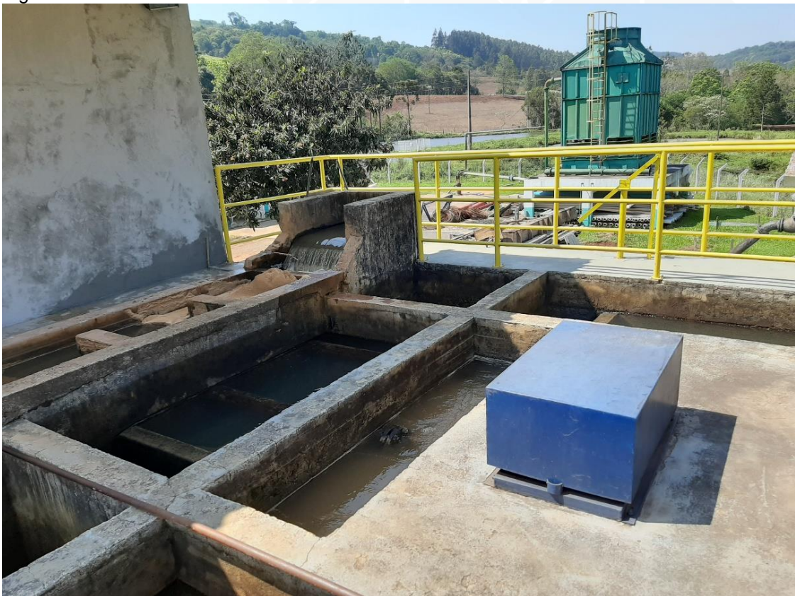
Figura 14: ETA – módulo em concreto.
