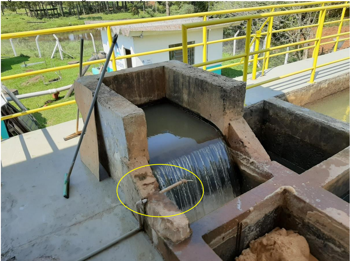
Figura 12: Entrada de água e Mistura Rápida – Módulo em concreto
