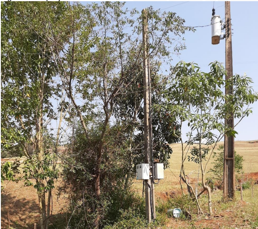
Figura 53: Captação Linha Santana da Bela Vista – Painelelétrico.
