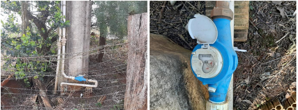
Figura 67: Macromedidor Multijato – QN 10 m 3 /h.
