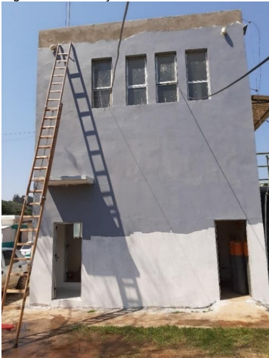
Figura 17: Edificação em reforma – Casa de química/Laboratório
