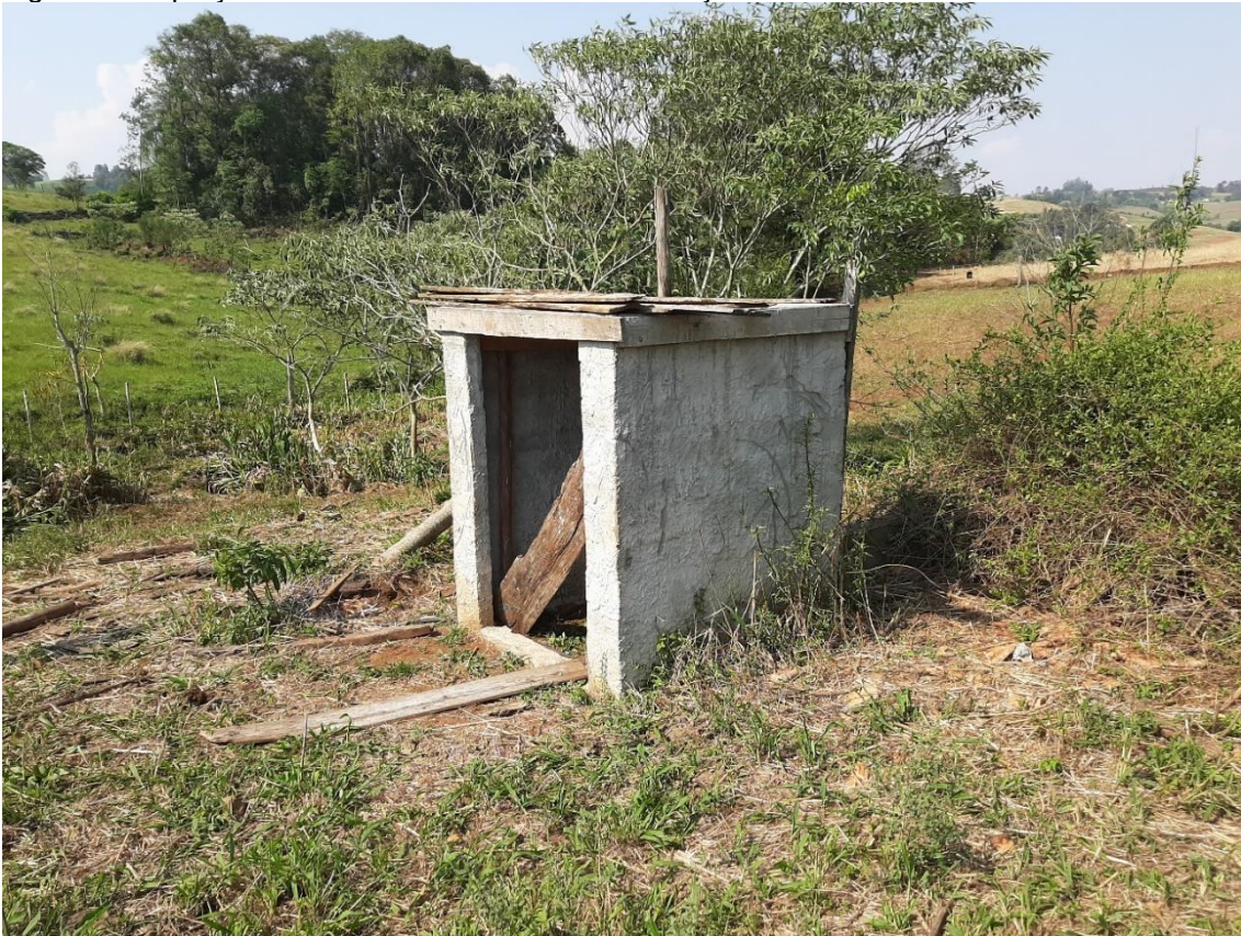
Figura 52: Captação Linha Santana da Bela Vista - Poço
