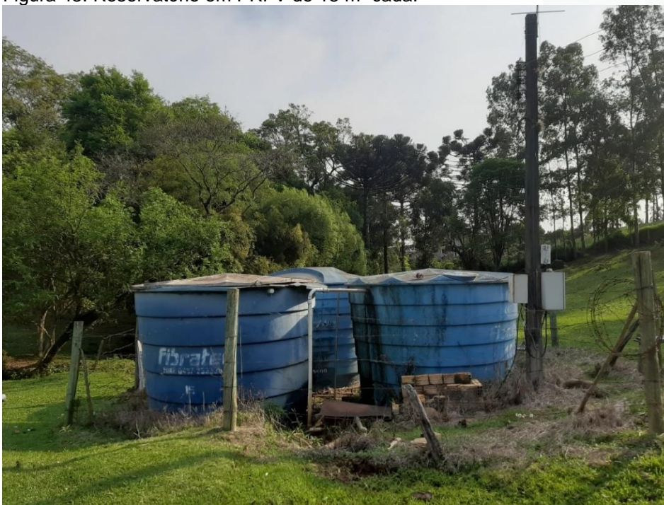
Figura 43: Reservatório em PRFV de 15 m 3 cada.
